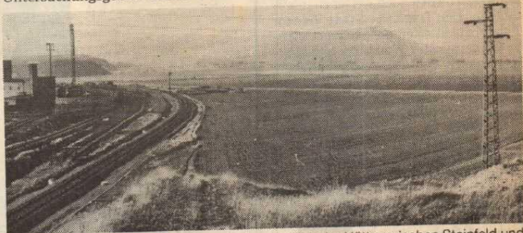
71 Hektar ist allein das Gelände groß, das nördlich der Hütte zwischen Steinfeld und Harlingerode durch Bepflanzung saniert werden soll. Foto: Tempes
